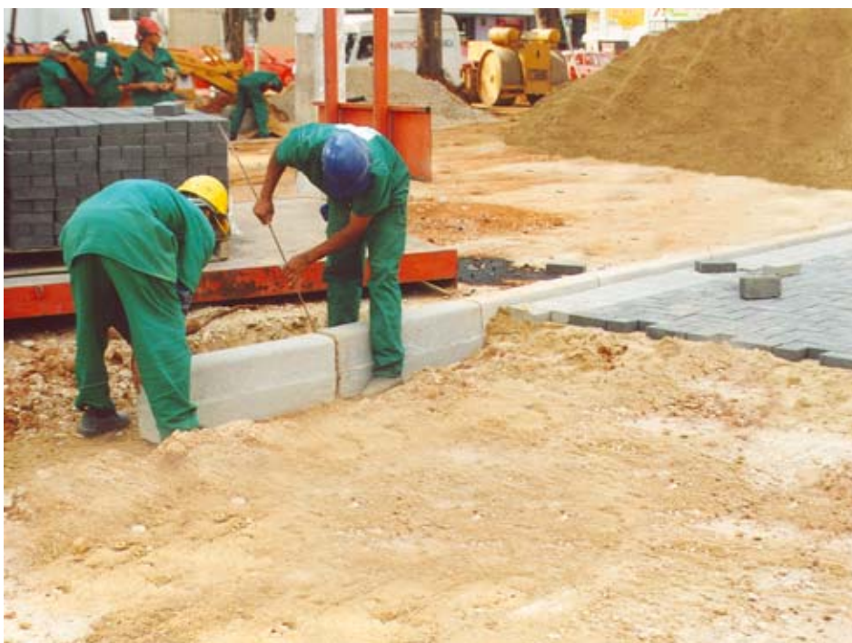
Figura 3 - Colocação de confinamento externo (meio-fio)
