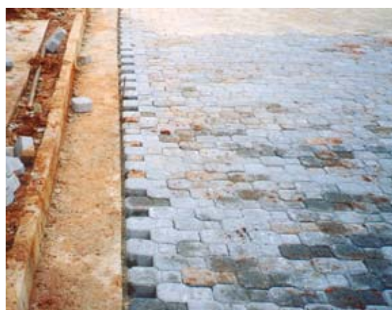
Figura 4 - Confinamento externo (meio-fio e sarjeta)
