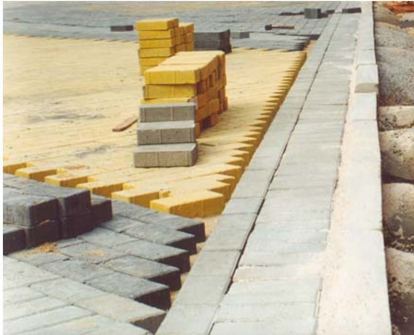
Figura 5 - Confinamento externo (meio-fio)
