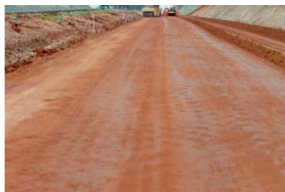
Figura 2 - Compactação do subleito/Fixação das cotas do pavimento
