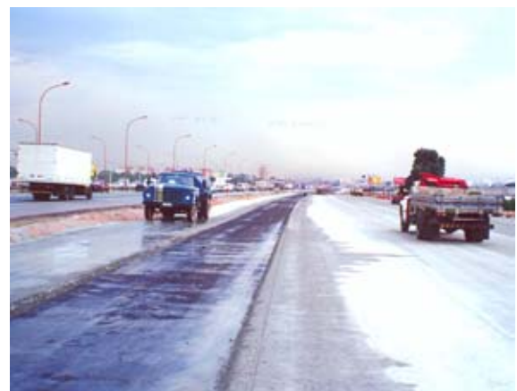
Figura 4 - Imprimação da base
