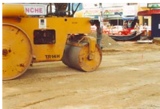
Figura 3 - Compactação da base granular
