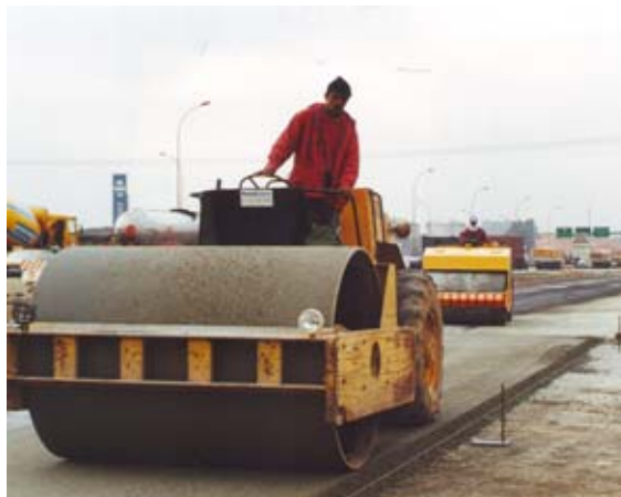
Figura 5 - Compactação da base de concreto rolado
